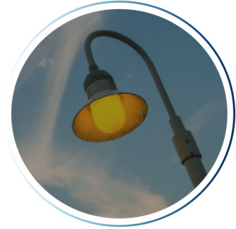
أعمال الكهرباء والإنارة
