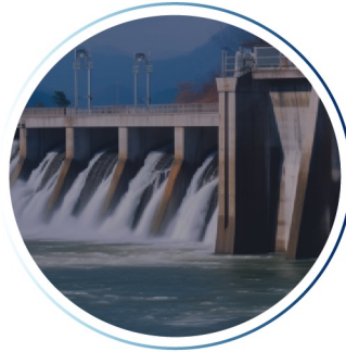
أعمال تصريف سيول الأمطار ومعالجة تجمعاتها
