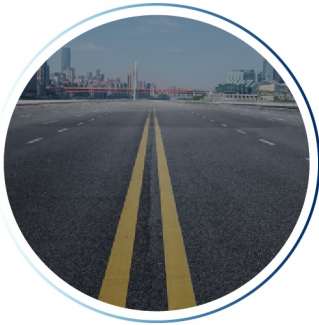
أعمال إنشاءات الطرق والسفلة
